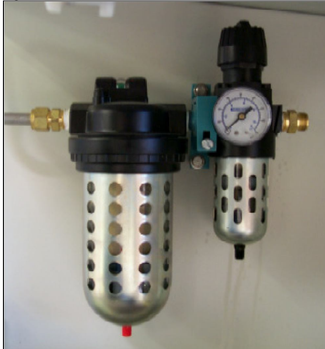
Рисунок 4-23: Изображение фильтра предварительной очистки / регулятора
