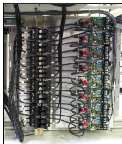
Рисунок 3-5: Панель КТУ и плавкие предохранители
